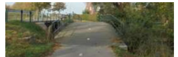
Brug over de Kromme Rijn in het Kromme Rijnpad
